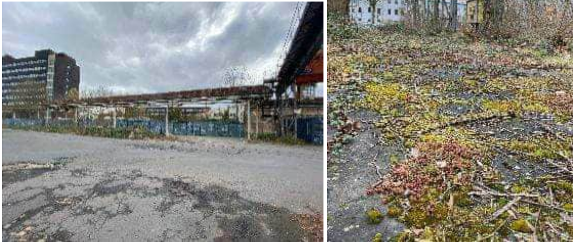
Abb. 2-19: Versiegelte Flächen Zwischen den Hallen
