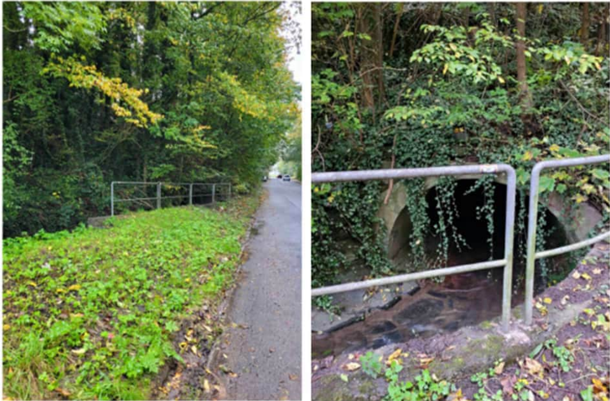
Abb. 2-21: Abschnitt des Angersbachs außerhalb des Geltungsbereichs mit Einmündung in die Verrohrung
