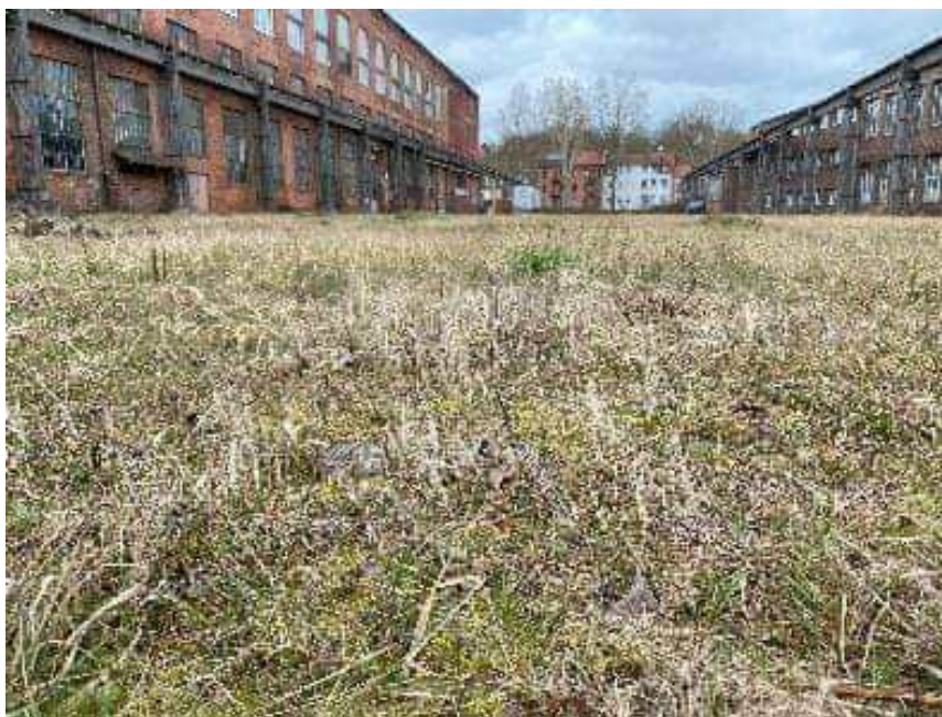
Abb. 2-18: Rasenfläche zwischen den Hallen (Nahaufnahme)
