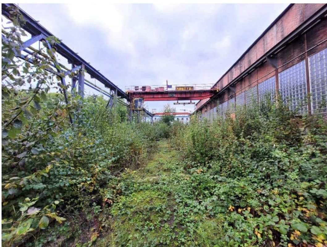
Abbildung 2-2: Brombeerflur im Bereich der Kranbahn beim Parkplatz (Aufnahmedatum: 08.11.2024)
