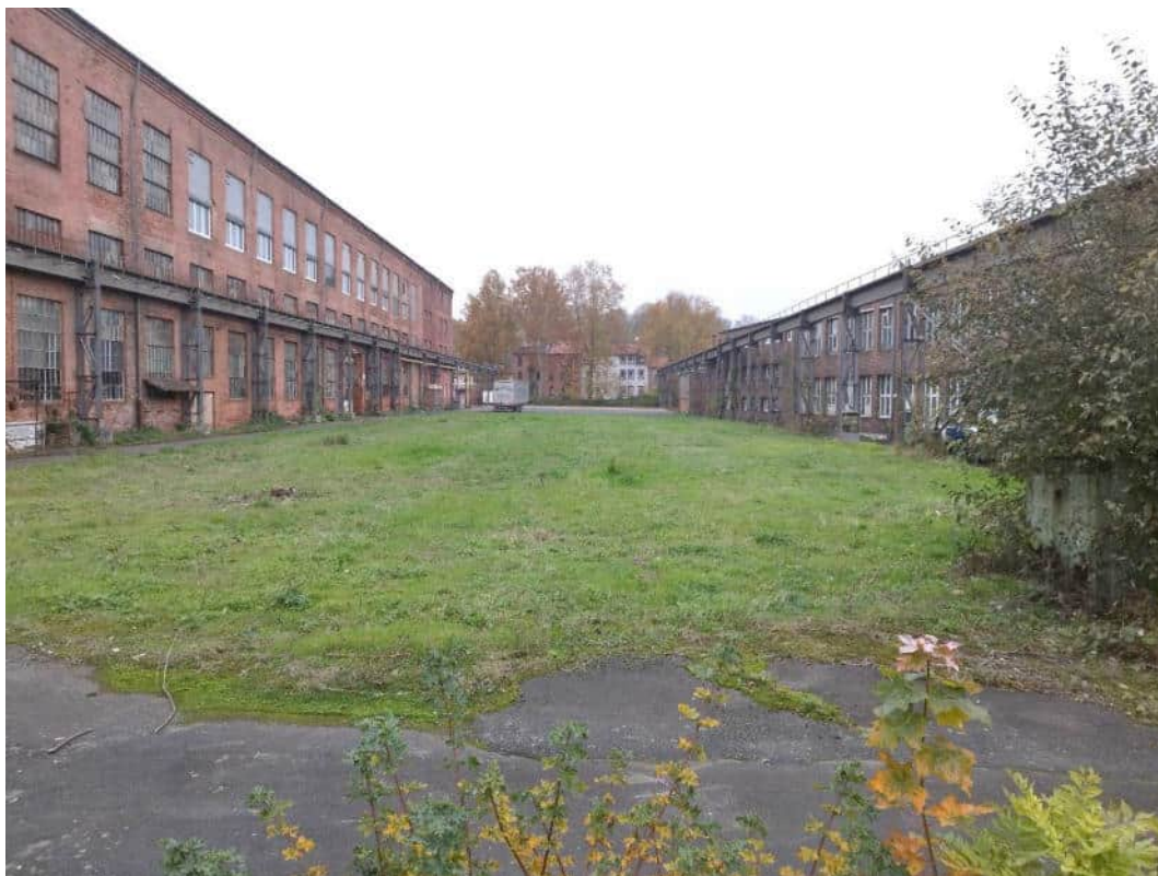
Abbildung 2-1: Grünfläche zwischen ehemaligen Werkhallen (Aufnahmedatum: 08.11.2024)
