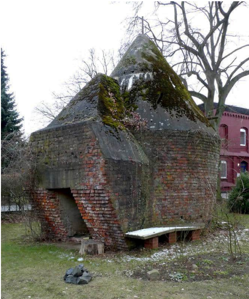
Abb. 31 Brandaustraße 10 (Foto: Th. Wiegand)
