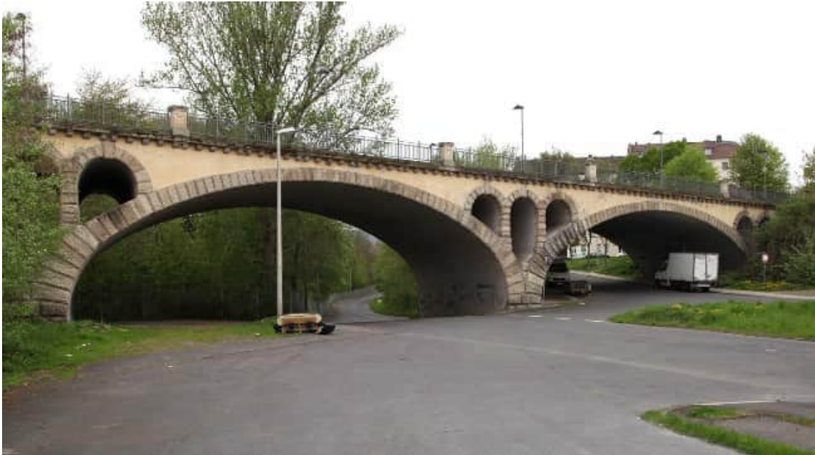
Abb. 33 Wolfhager Straße, Mombachbrücke
