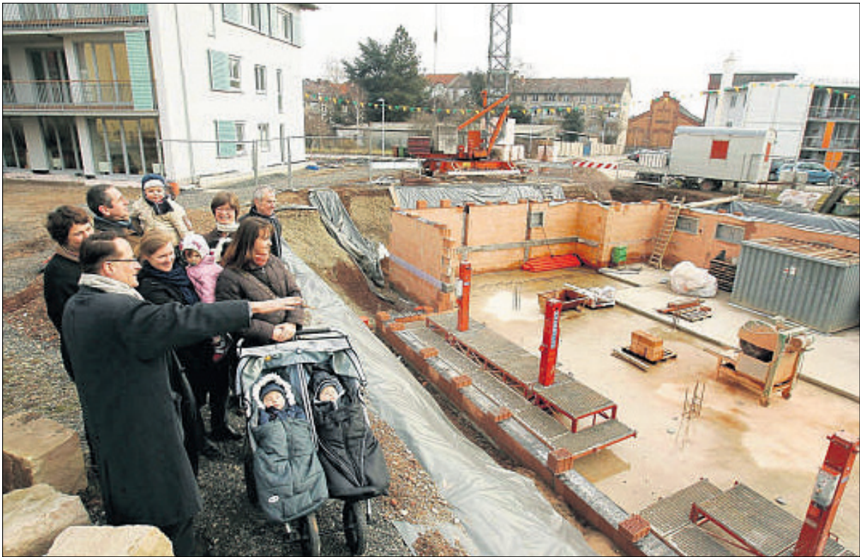
Der Bau nimmt Gestalt an: Zurzeit wird das fünfte Haus der Heilhaus-Siedlung in Rothenditmold gebaut. Dort werden eine Krabbelgruppe sowie eine Schule für schwer kranke Kinder einziehen, und es gibt Apartments für pflegebedürftige Menschen. Unser Foto zeigt künftige Bewohner und Nutzer. Vorn im Bild ist Gerhard Paul, Chef der Heilhaus-Stiftung, zu sehen. Foto: Socher
